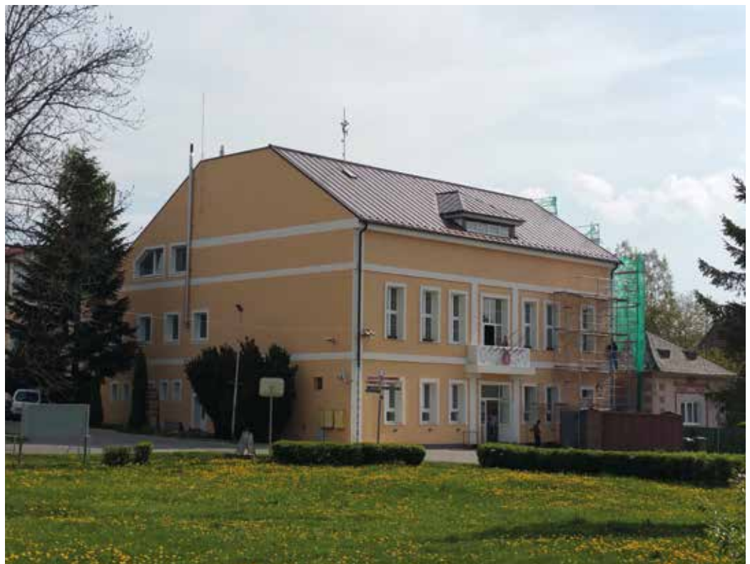
Obecný úrad po realizácii zateplenia (foto: Tomáš Bujna)
